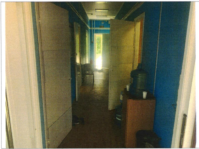
Фото № 7 – Пути движения внутри здания (двери).
