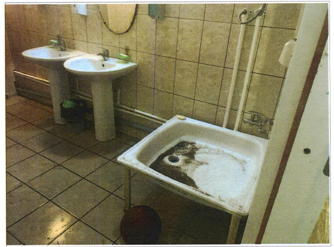
Фото № 10 – Санитарно-гигиенические помещения
