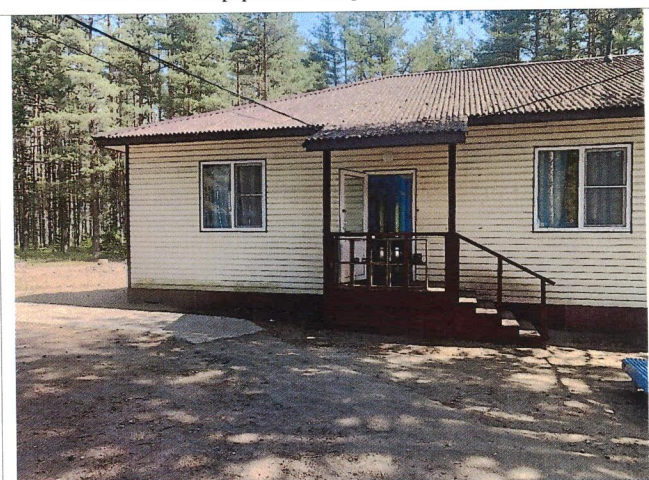
Фото № 4 – Главный вход. Наружная входная лестница
