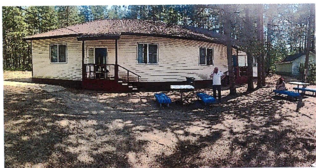
Фото № 3 – Подходы к объекту
