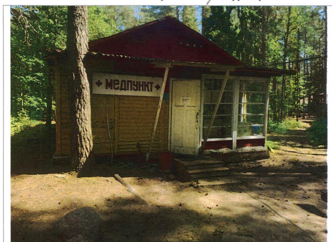
Фото № 3 – Главный вход. Входная площадка. Наружная лестница
