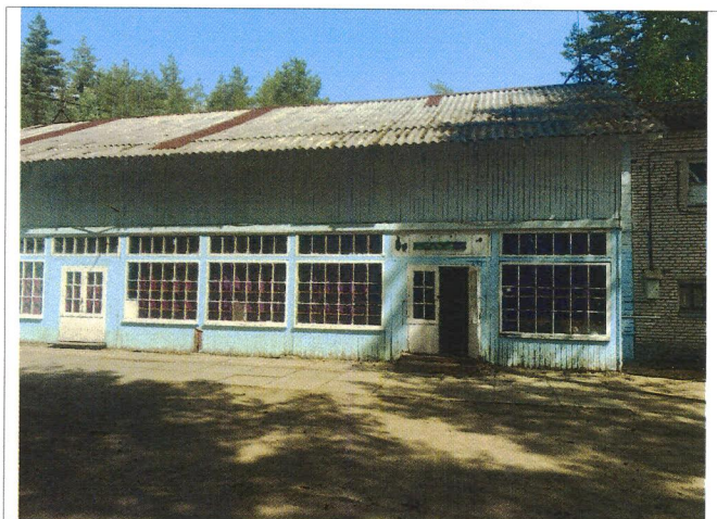
Фото № 4 – Главный вход. Входная площадка.
