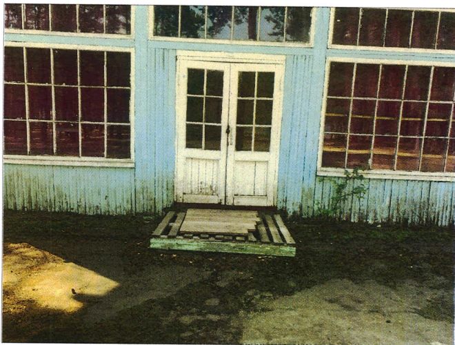
Фото № 9 – Запасной выход.
