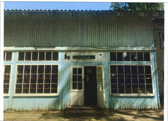
Фото № 5 – Входная дверь.
